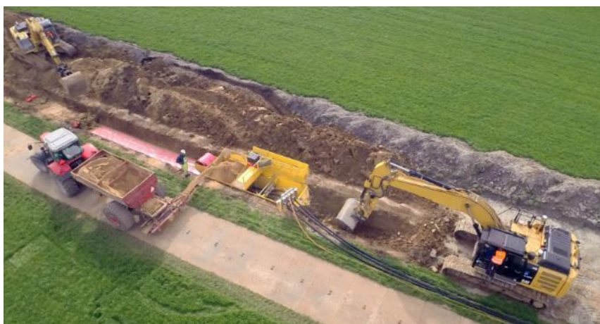
Figur 2.5: Kabelgravekasse i funktion, hvor kun en kort strækning af kabelgraven står åben.
