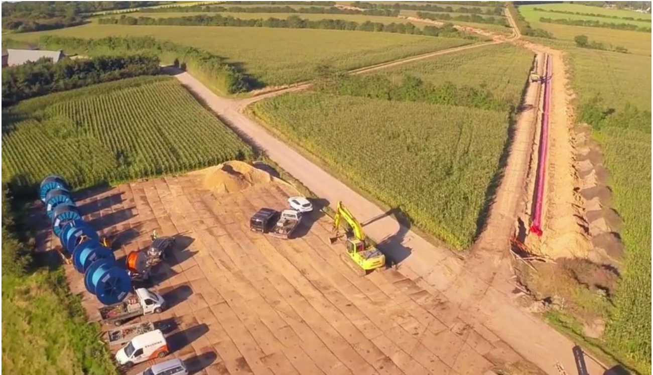
Figur 2.2: Eksempel på åben kabelgrav med arbejdsbælte langs tracéet og en midlertidig arbejdsplads til oplag materialer.
