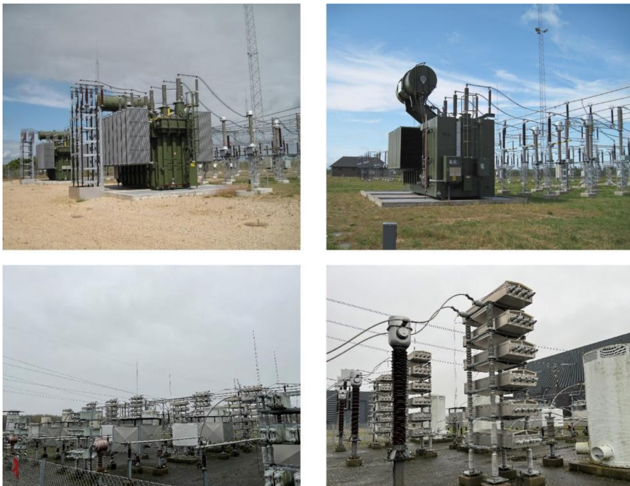
Figur 2.8: Eksempel på transformere og kompenseringspole på transformerstation, der er placeret på betonfundament (øverst) og forskellige typer af filtre nederst. På de to øverste billeder ses eksempler på de høje lynfangsmaster.
