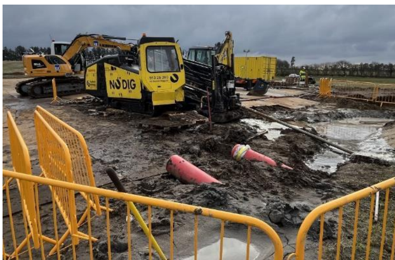
Figur 2.7: Eksempel på boregrube for styret underboring.
