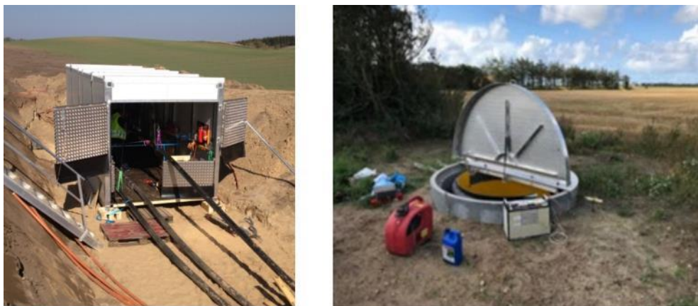
Figur 2.4: Midlertidig muffegrav, hvor kabler samles samt linkboksbrønd, der vil være synlig efterfølgende.
